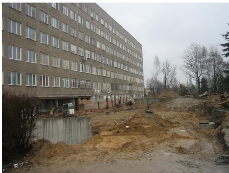
Prace budowlane na terenie przy szpitalu. Fot. K. Różycka.
